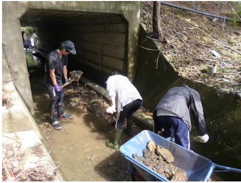
図 12 土砂除去作業 (2019年9月3日筆者撮影)
